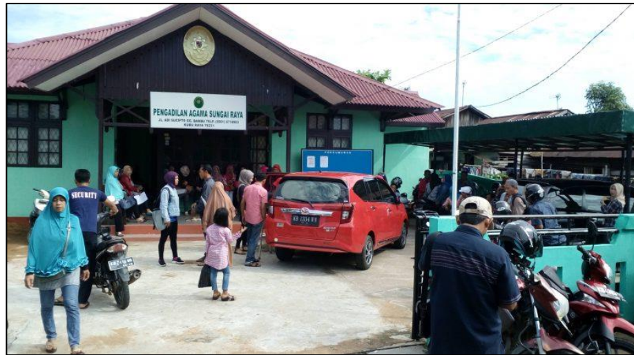
Gambar 9 - Foto Gedung Pengadilan Agama Sungai Raya
